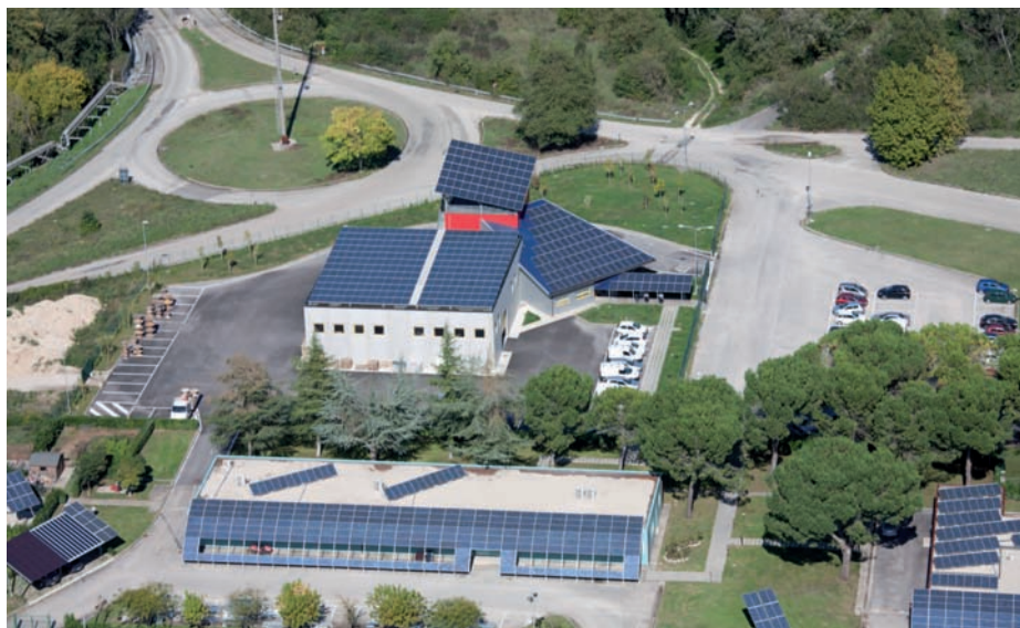
La sede di Genera, a Narni (Tr)
